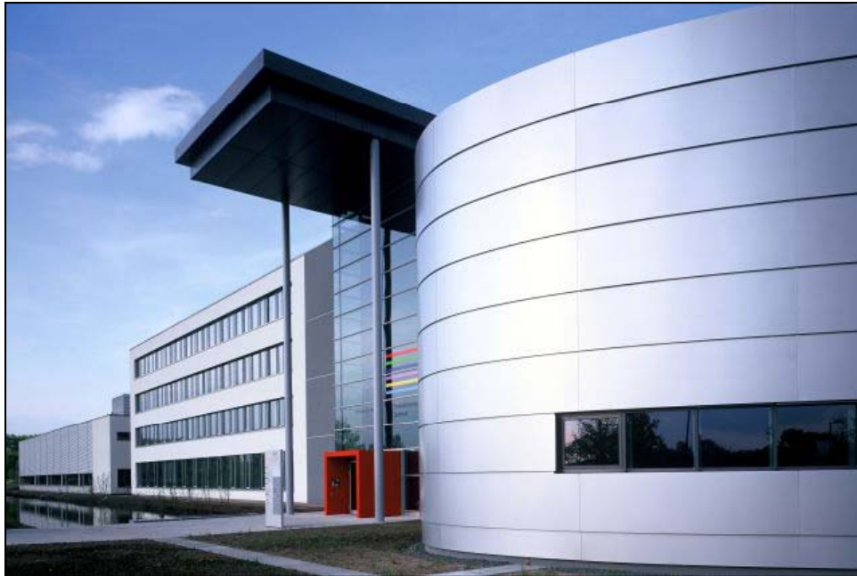
Bild: Eingang des Produktionstechnischen Zentrums Hannover (PZH) mit Hörsaal und Gebäuden des IFW.
